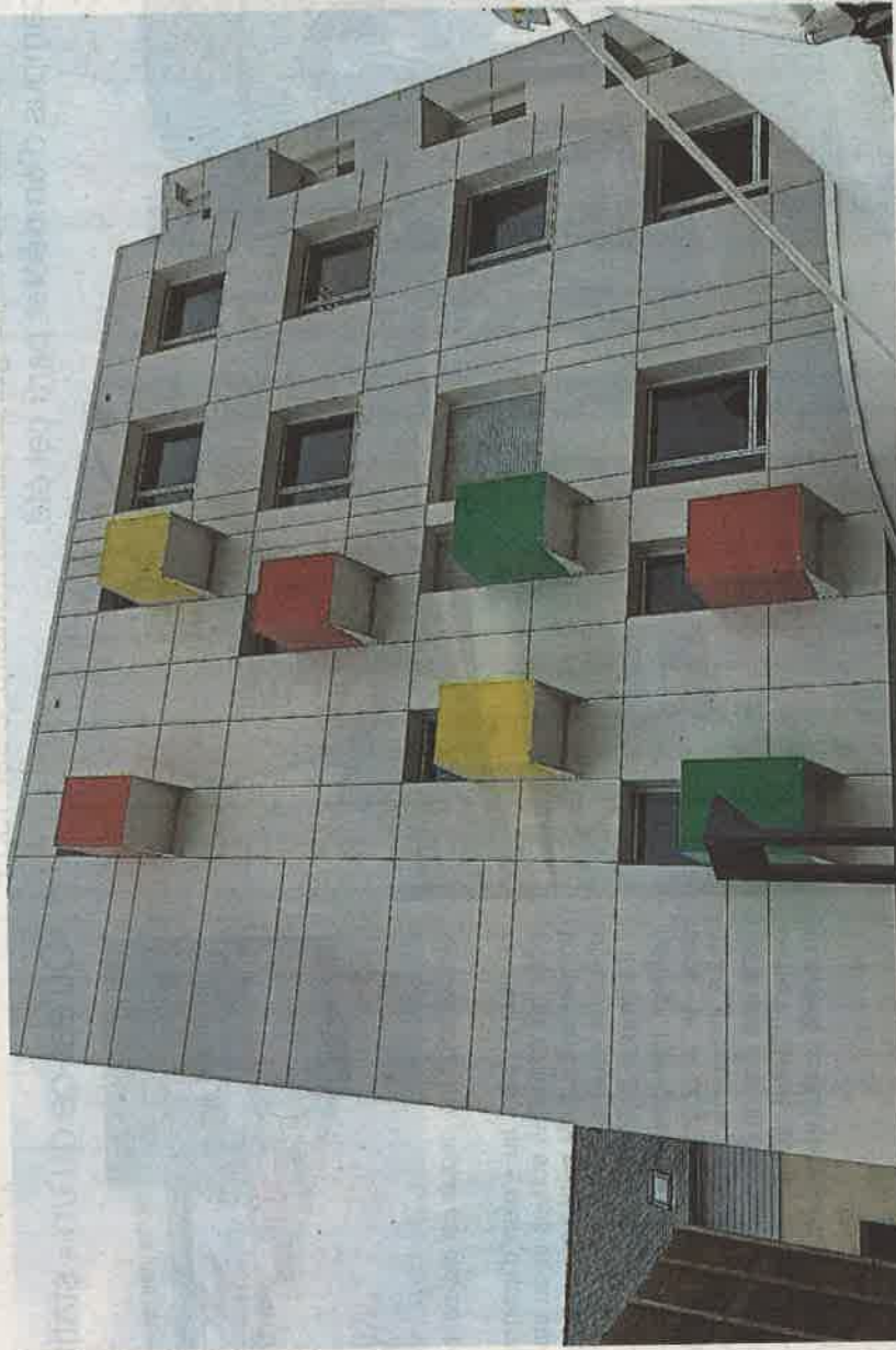
Situé rue de Fougères, l'immeuble abrite 26 logements constitués de T1 et de T2. Il porte le nom de Daniel Ravier, ancien directeur de l'association Saint-Benoît-Labre, décédé en 2011.
