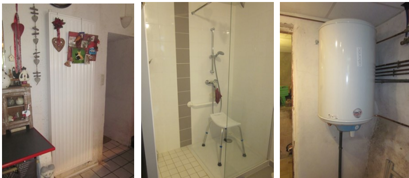
Photos après travaux
